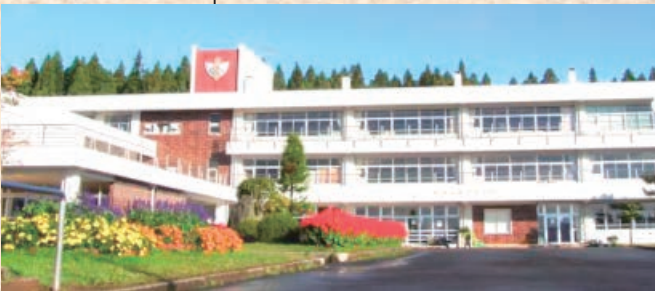
羽黒前(あさひ台)にあった頃の五城目小学校校舎(1968~2020年、昭和43~令和2年)
